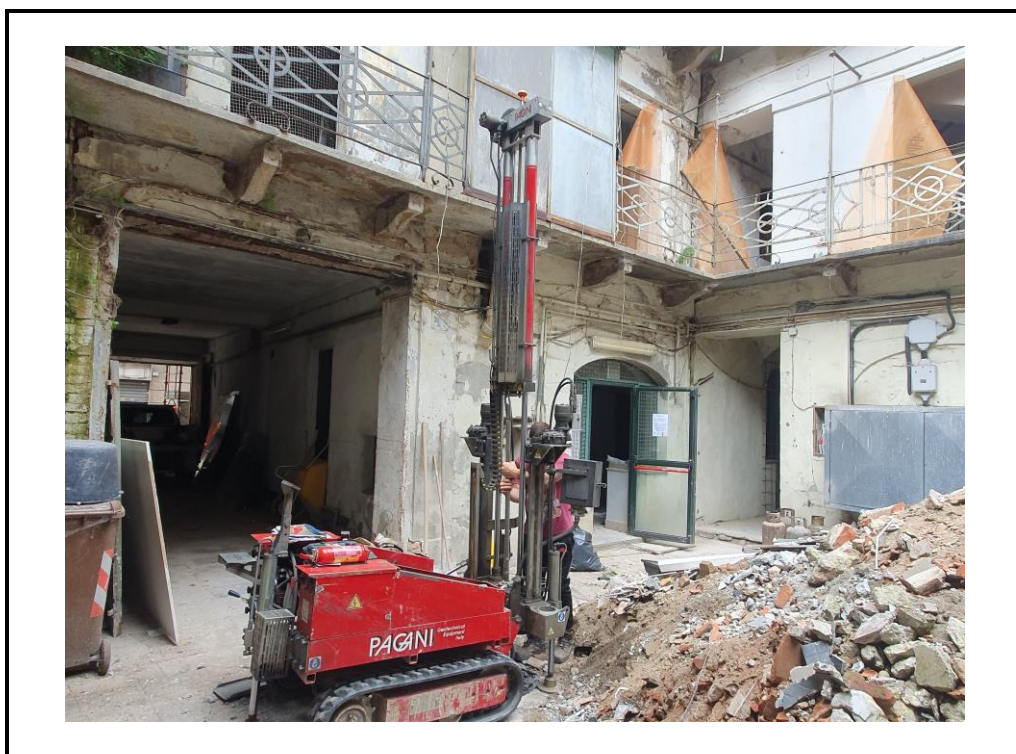
Foto 2: Posizionamento prova penetrometrica DPSH 1 (altra prospettiva).
