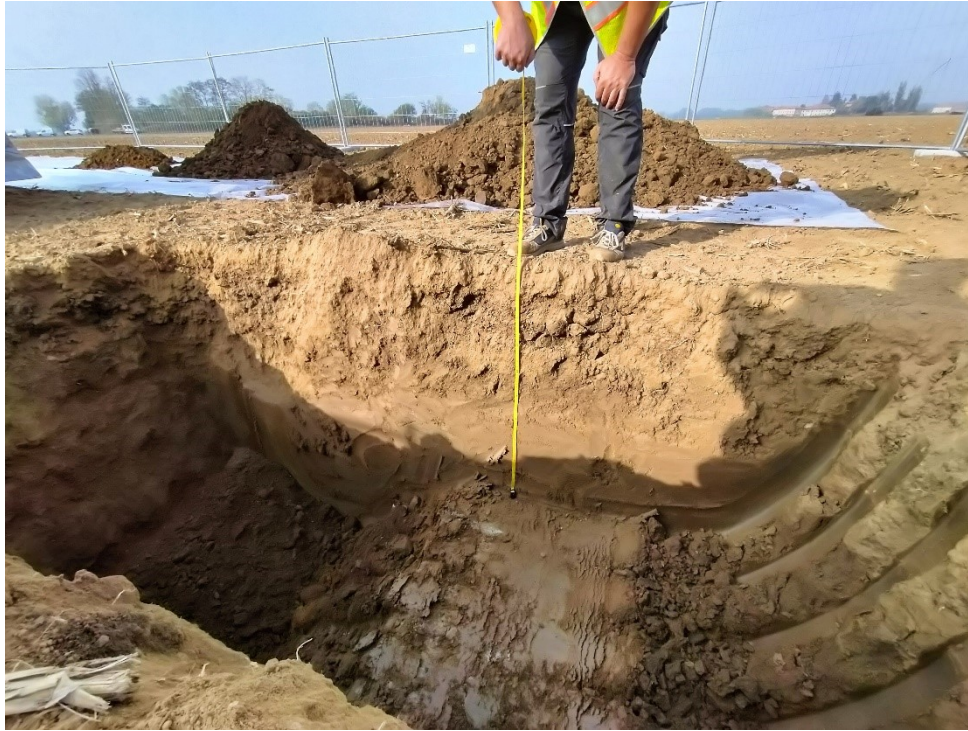
Foto 4. Campionamento terreno da trincee esplorative per la ricerca dei canali
